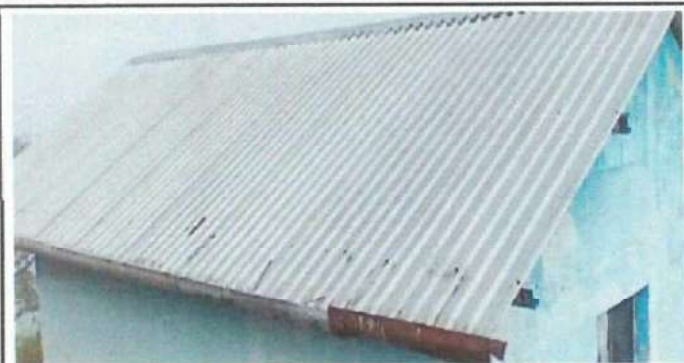
Foto 1: Sustrucion de cubierto de lámina por deterioro y filtración de agua.
