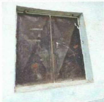
Foto 7: Sustrucción de ventana de metal por deterioro de óxido.
